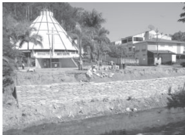
Contenção de encostas nas margens dos córregos
