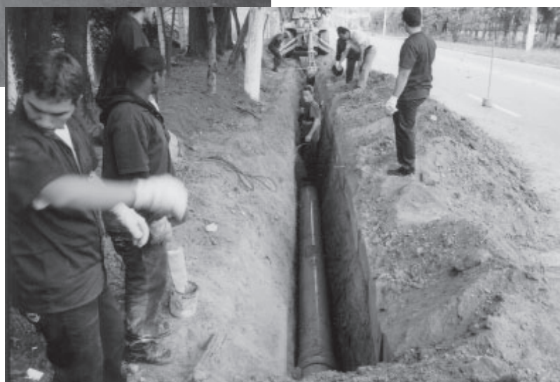
Complexo Roma - Serviço do Saae VR, abrindo corredores ao longo da Avenida Tancredo Neves, para levar água potável do Jardim Belvedere até o complexo Roma, através de bombeamento. Obra prevista para 60 dias, resolve a questão do abastecimento de água potável nos bairros do complexo.
