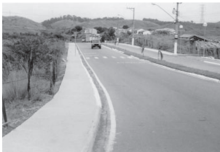
Calçadas para pedestres no Jardim Cidade Nova, mais 1.455 m 2 .
