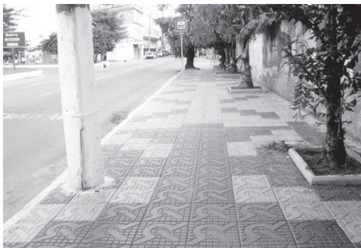
Retiro: Construção de 31.250 m 2 de calçadas
