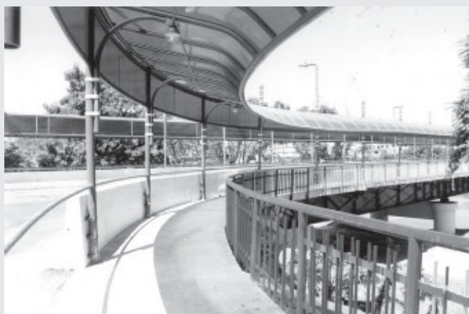
Cobertura em estrutura metálica das passarelas da Ponte Pequetito Amorim
