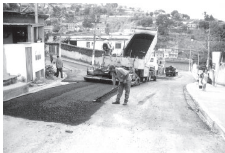
Flagrante do recapeamento asfáltico em várias ruas do bairro Coqueiros. O IPTU pago volta em obras públicas.
