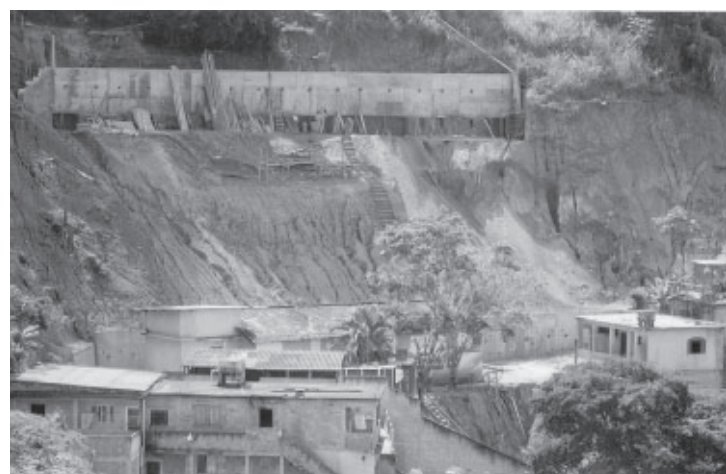
Contenção de encostas com cortina atirantada na Rua 5-B, no bairro Belo Horizonte. Garantia da integridade física e proteção do patrimônio dos moradores
