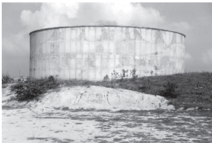
Implantação de 4.500 m de rede de água, dois conjuntos de bombas e construção do reservatório de água com capacidade de 3. 000.000 de litros no bairro Água Limpa.
