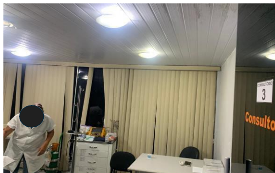
Consultório 3 - Janela Curva
