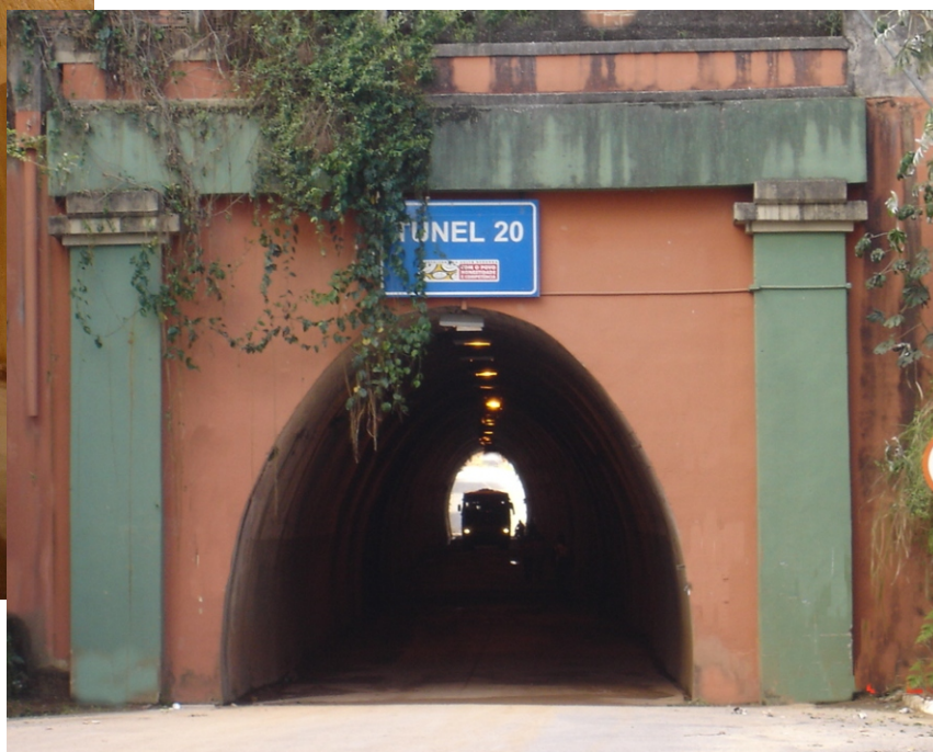
Túnel 20 Construção única no gênero no município. Remanescente da antiga estrada de ferro que interligava Barra Mansa e Barra do Pirai.
