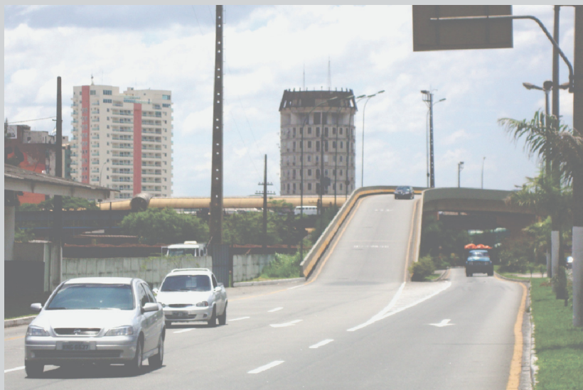
Rodovia BR-393 (Rodovia Lúcio Meira) - Viaduto 17 de Julho
