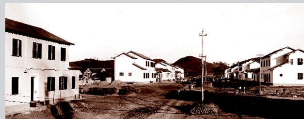
Rua 33 década de 40 - construção dos hotéis para solteiros
