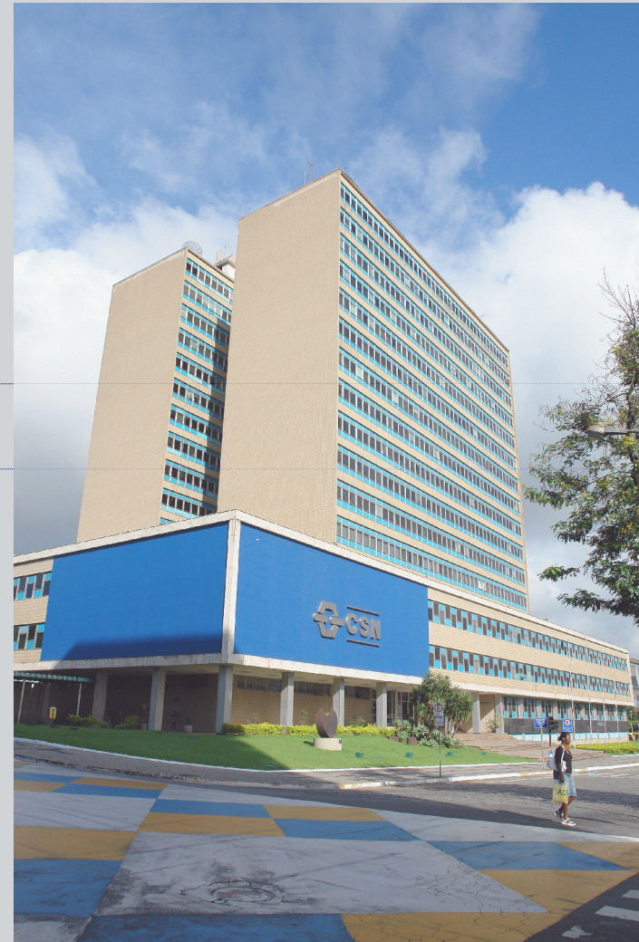
Vista Lateral do Escritório Central
