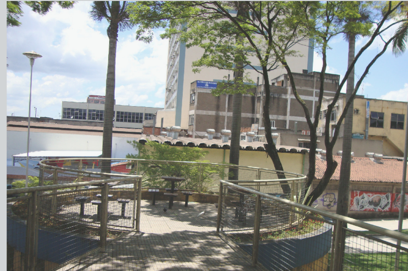
Cabeceira do Viaduto Nelza Mafort Hott
