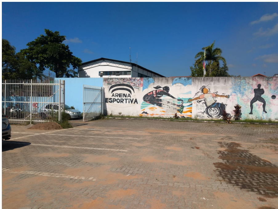
Foto 04 – Entrada da Unidade. Espaço pode ser usado pelo caminhão/guindaste. Comprimento portão aprox. 5,50m.
