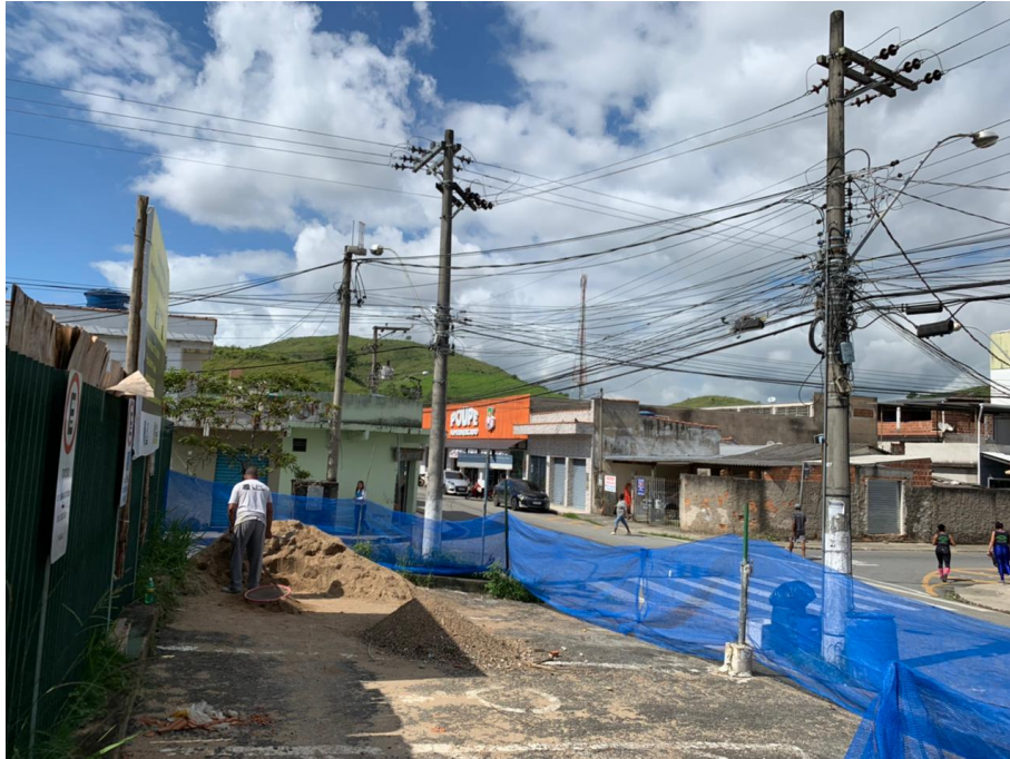
Foto 03 – Entrada da Unidade. Espaço pode ser usado pelo caminhão/guindaste
