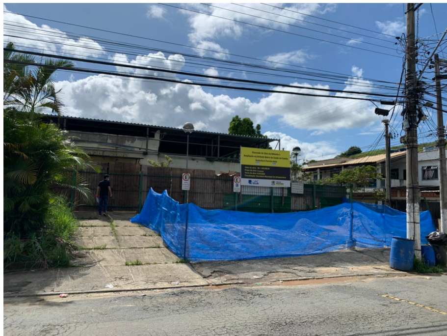
Foto 02 – Entrada da Unidade. Espaço pode ser usado pelo caminhão/guindaste
