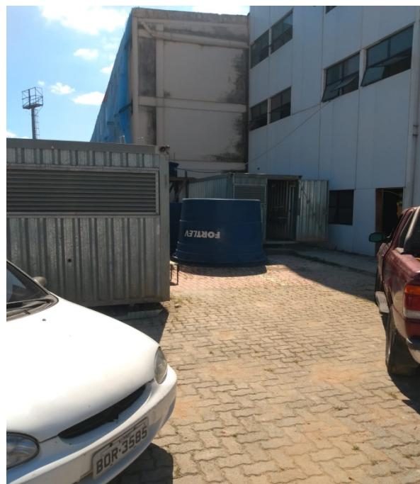
Foto 06 – Local de instalação do reservatório. O mesmo será instalado no local onde o container aparece na imagem.
