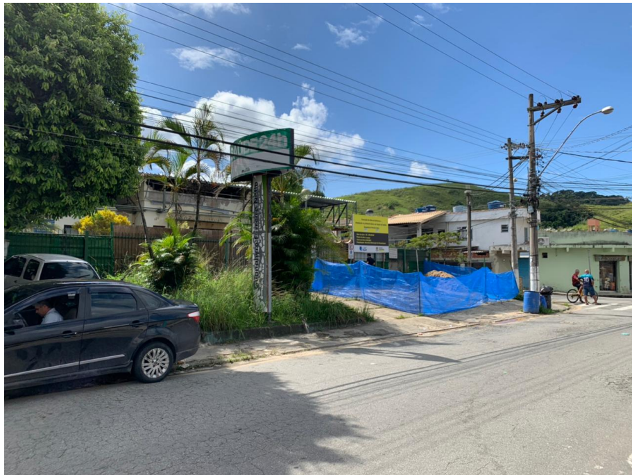
Foto 01 – Entrada da Unidade. Espaço pode ser usado pelo caminhão/guindaste
