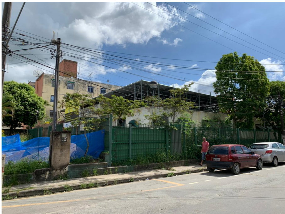
Foto 04 – Local onde será instalado o reservatório Vista de fora
