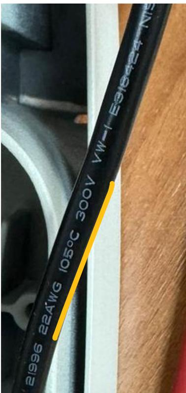
FIG.1 A e B- FIAÇÃO INTERNA COM CAPACIDADE DE CONDUÇÃO DE CORRENTE SUPERIOR À DEMANDA DE ENERGIA DA LUMINÁRIA
