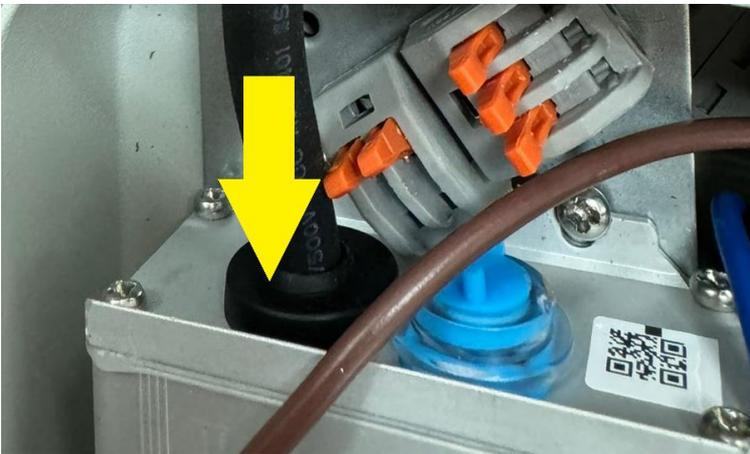
**FIG 4- CABO DE ALIMENTAÇÃO COM DESTAQUE PARA GAXETA EM SILICONE DESTINADA À PROTEÇÃO DOS CONDUTORES**
